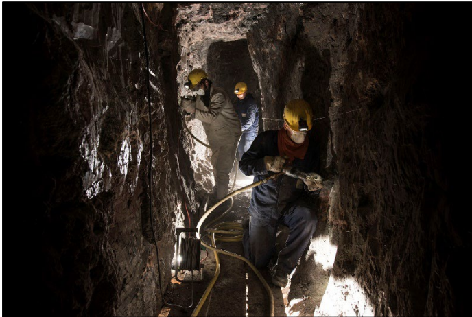
Arbeit untertage: Putzen der Profile mit dem Schremmhammer.
