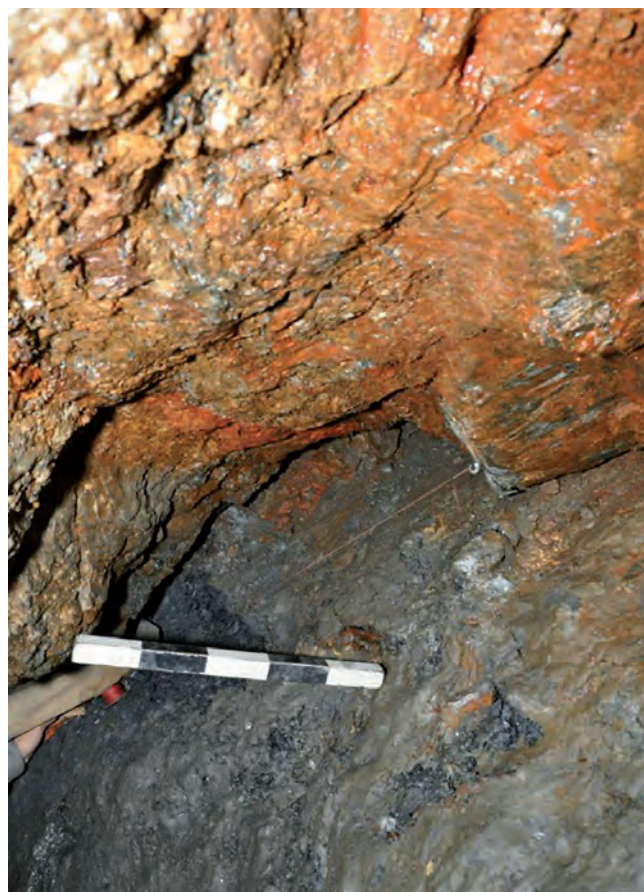
Abb. 52: Arthurstollen, Tiefbau, Oststrecke: oberer Teil eines Streckenprofils des neuentdeckten Grubenbauteils, eines von OSO zugeführten schrägen, „tonnlägigen“ Auffahrungsbaues
