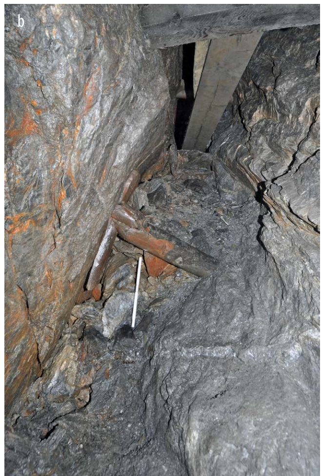
Abb. 78: Im Arthurstollen wurden im grubentiefsten Betriebspunkt Dokumentationen und Räumungen vorgenommen, a. die Förderkette, b. das OSO-Profil mit mittelbronzezeitlicher Druckzimmerung; Fotos: Foto: Th. Stöllner, RUB/DBM.
