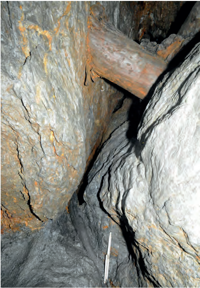
Abb. 97: Arthurstollen, Tiefbau bei Lfm. 4650, offener Verhau, Engstelle mit Sohlabsatz und massiver Querstempelzimmerung (Foto: DBM/RUB, Th. Stöllner).
