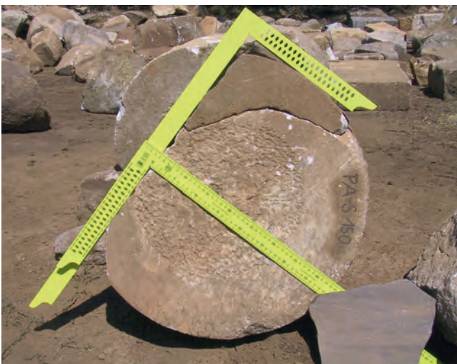
Abb. 50: Säulentrommel, Anathyrose der Lagerfläche (Foto: H. Büsing).
