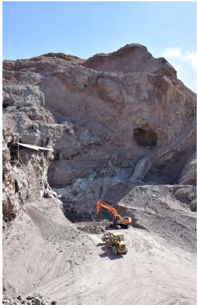
Abb. 120: Um das große Nordprofil bewältigen und vor allem die untersten achämenidischen Grubenbauteile freilegen zu können, musste schweres Gerät eingesetzt werden; Foto: DBM/RUB, Th. Stöllner.
