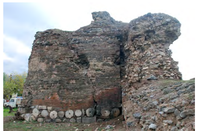
Abb. 99: Spolien verbaut im Sockel des Turms AT 39 der inneren Mauer A; Foto: A. Dalyanci-Berns.
