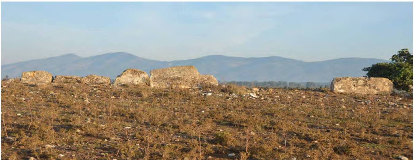
Abb. 53: Milet, Humeitepe, Polygonalmauer; Foto: Ch. Berns.
