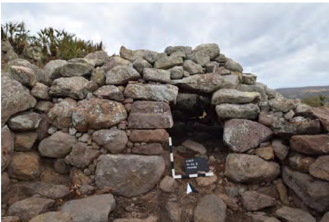
Abb. 162: Eingangsfassade von Capanna B mit Kraggewölbe und Keilsteinen; Foto: C. von Räden.
