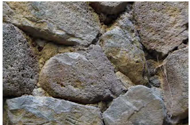
Abb. 163: Keilstein im Mauerwerk der Nura von Barumini; Foto: C. von Räden.
