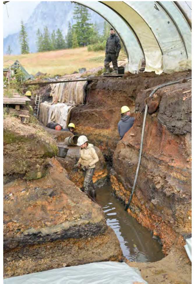
Abb. 147: Troiboden 2018: Sanierungs- und Grabungsarbeiten im Vorfluter des Profils, Foto: DBM/RUB, K. Koszczinski.
