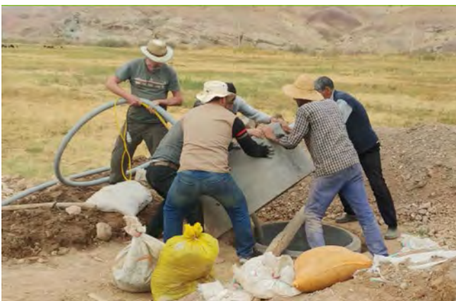
Abb. 147: Nach der Lokalisierung einer geeigneten Wasserlinse durch Geo- elektrik, wurde an dieser Stelle nach lokaler Methode in Handarbeit ein Brun- nen gegraben. Danach wird der Brunnen auf ausreichenden Wassernachfluss getestet und das Wasser auf Schadstoffe analysiert (Foto: AFM Frankfurt, N. Bagherpour Kashani).
