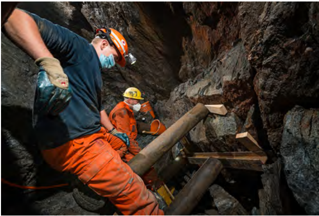
Abb. 168: Räum- und Verzimmerungsarbeiten im Bereich des Firstverbruches der unteren Deponie im Tiefbau, Fst. 4650 (Foto: DBM, P. Thomas).
