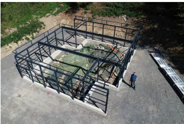
Abb. 165: Der Schutzbau am Gerhardseifen während seiner Errichtung 2019 (Foto: M. Zeiler).
